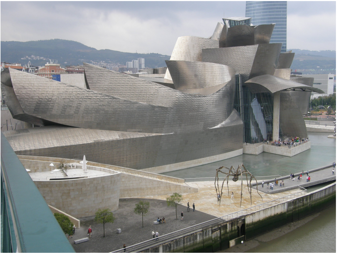
Vue d'ensemble du Musée Guggenheim de Bilbao (Photo G. Kuntz)
