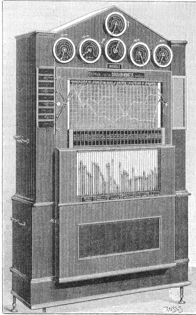
Fig. 1. — Le Diagrammètre du colonel Kozloff.
